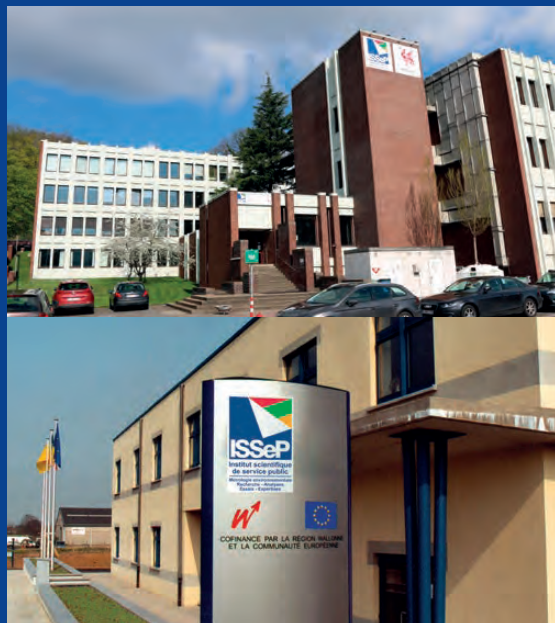
En haut : siège et site d'exploitation à Liège En bas : site d'exploitation à Colfontaine
