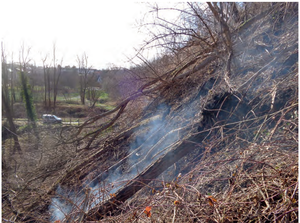
Talus de remblai minier charbonneux en combustion
