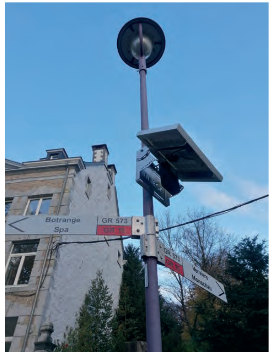
Ministation de la qualité de l'air alimentée par un panneau solaire et installée à Eupen pour le projet inédit
