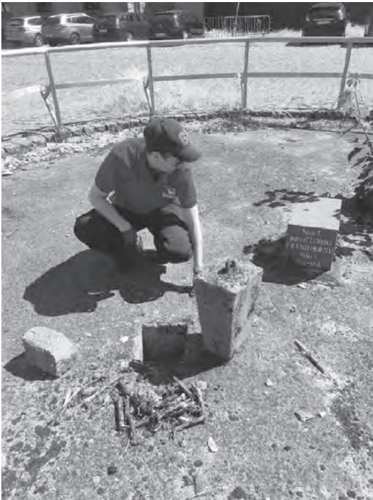
Surveillance des anciens ouvrages miniers sécurisés
